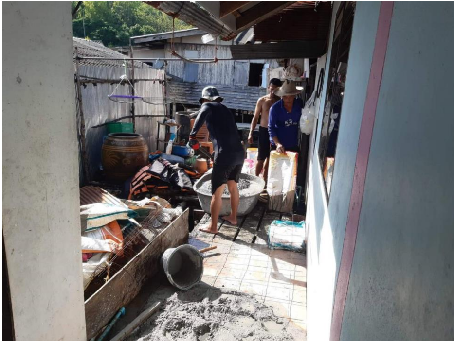
ภาพที่อยู่อาศัยคนพิการ ระหว่างดำเนินการปรับปรุงสภาพแวดล้อมที่อยู่อาศัยคนพิการ นางรัตนา วาริศรี อยู่บ้านเลขที่ ๓ หมู่ที่ ๓ บ้านเกาะไม้ไผ่ ตำบลเกาะปันหยี อำเภอเมือง จังหวัดพังงา
